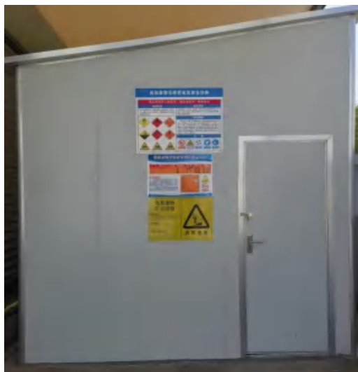
危废暂存间（外）
